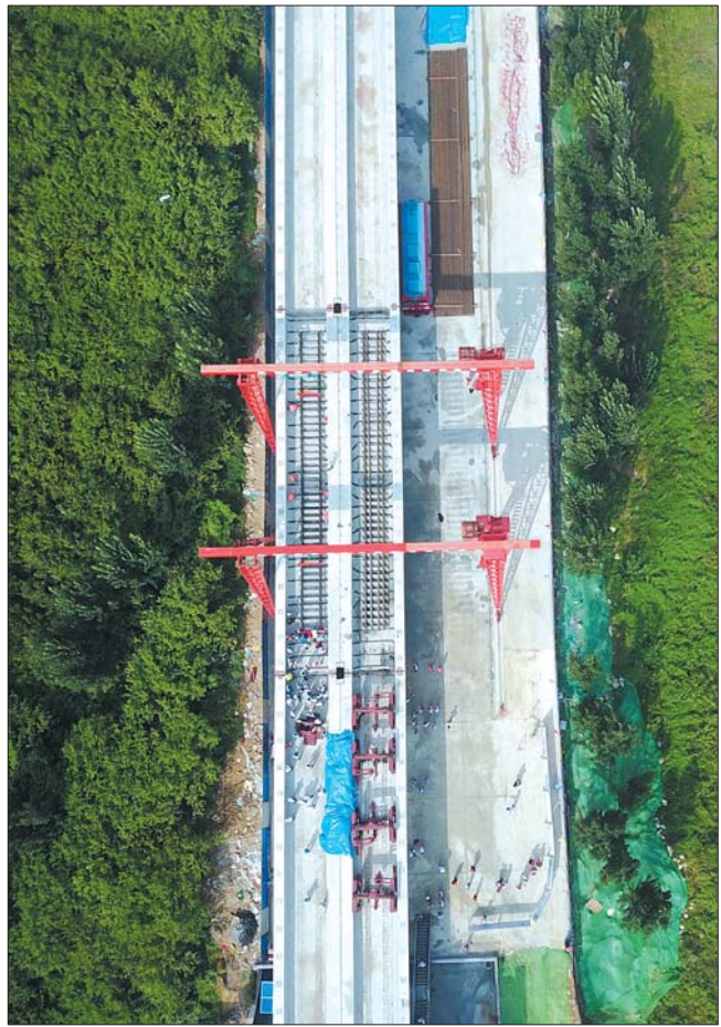
中铁一局铺轨工人操作着龙门架,将一节25米轨排顺利铺装到高架桥面线路上,这标志着济南首条地铁正式进入铺轨阶段,泉城人的“地铁梦”更近了。
