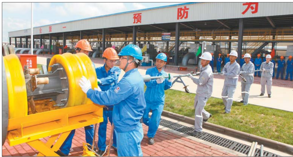
8月22日,青岛港职工将清管器推入发球筒中,准备开启阀门。 本报记者 赵波 摄
