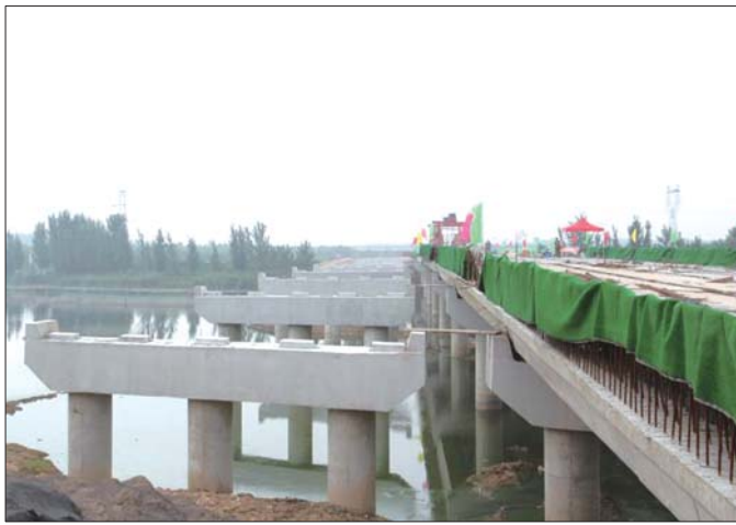
大桥主体已现雏形。本报记者 邢孟 摄
