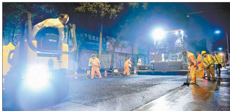
凌晨2时,山大南路施工段沥青铺设完毕。
