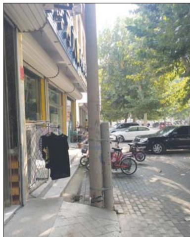
“伤人”线杆不远处,另一根底部断裂的线杆进行了加固。
