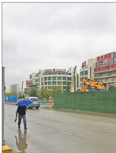
时代总部基地附近正在施工。
