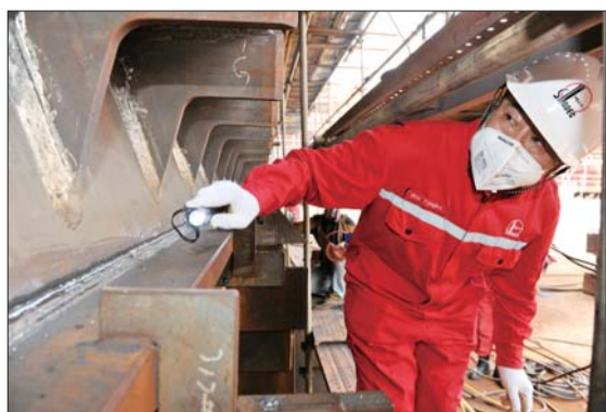
精细检查每一道焊缝。
