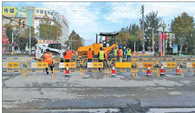
开元大街与龙海路交叉口处正在进行施工。
