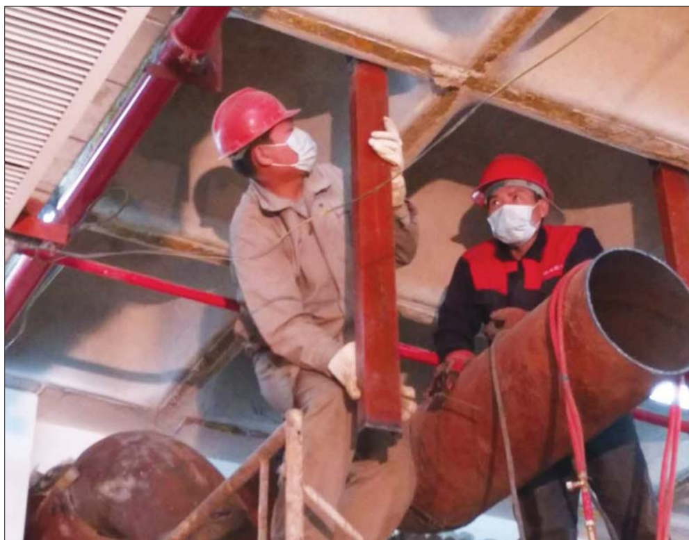
张师傅站在5米高的脚手架上固定支架。本报记者 孙璇 摄
