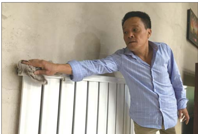
大多数村民的家中,暖气片已经安装完毕。本报记者孟杰摄
