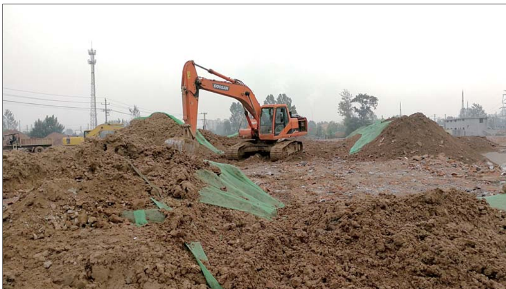
八一路施工现场。本报记者 邢孟 摄
