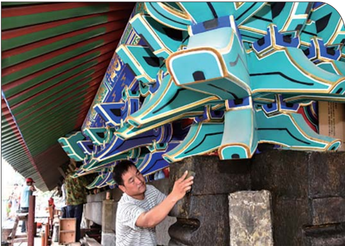
在孔庙对古建筑内部彩绘进行修复。
