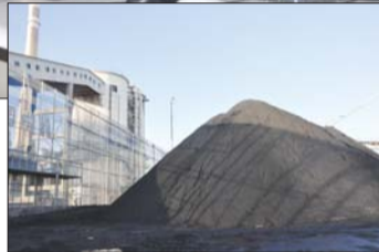
▶ 储煤堆成了小山够用30天以上。 记者 李怀磊 摄
