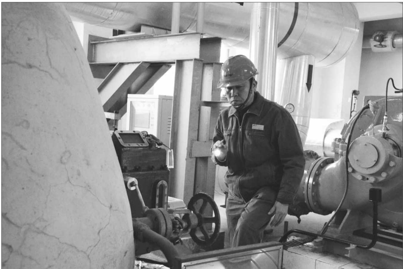
苏滨手持手电筒检查热网小汽轮机。本报记者 孙璇 摄
