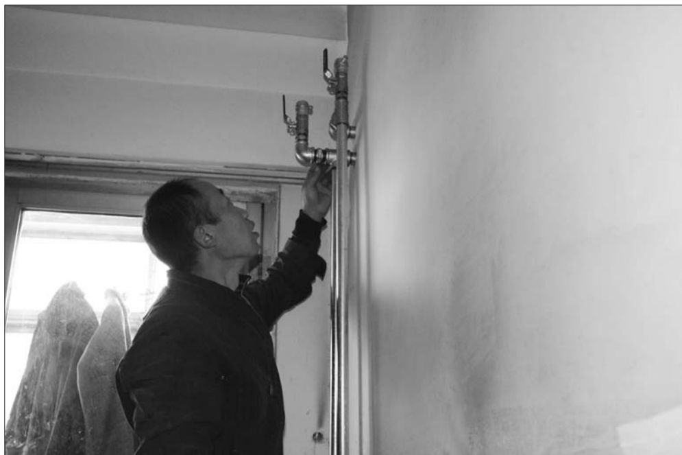
工作人员为新用户家中管道排气。本报记者 孙璇 摄
