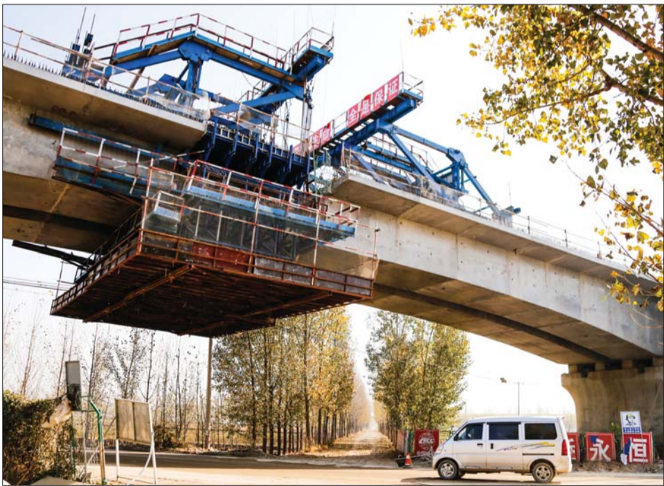
建设中的鲁南高铁。
