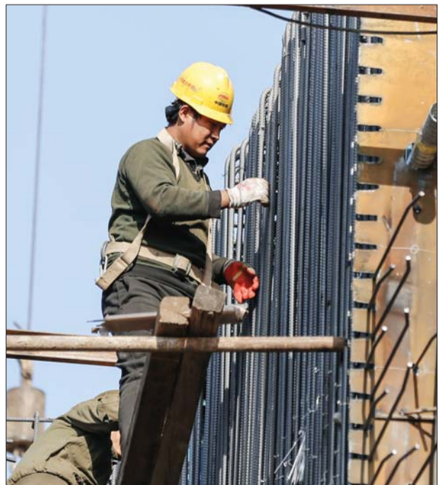
工作人员正在施工中。
