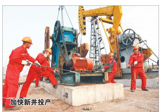
11月13日下午4时许,胜利油田鲁明济北采油管理区同台井曲9-斜244、曲9-斜247井提前组机完成,进入作业投产阶段。为确保新井高效投产,管理区维修站利用两口同台井未完钻期间,将要转入的闲置抽油机做好保养工作,并将钢丝绳、撬杠、水平仪等工具提前准备完善。充分有序的准备工作,让一天才能完成的工作量9个小时完成。据了解,11月份以来,济北采油管理区针对当前生产形势,开展"上产30天,日油要上618"活动,让精细管理、优化运行,为完成年度目标任务打下坚实的基础。
