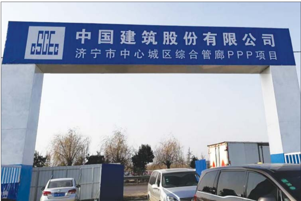
济宁市中心城区综合管廊PPP项目正在建设中。 本报记者 晋森 摄
