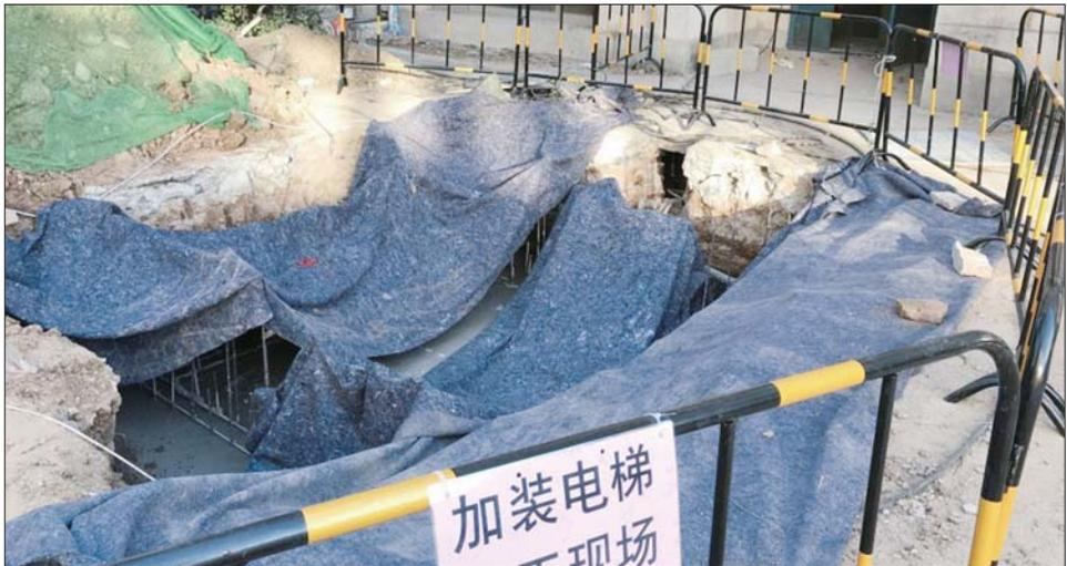
英雄山路201号电梯加装施工现场,浇灌水泥桩工作已完成,正等待晾干。
