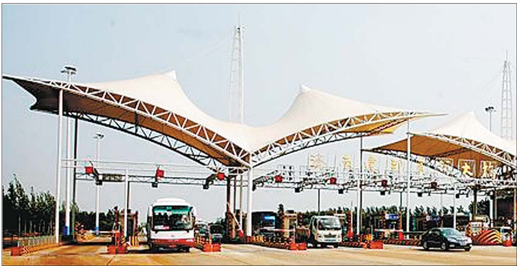
济南建邦黄河大桥收费站。(资料片)
