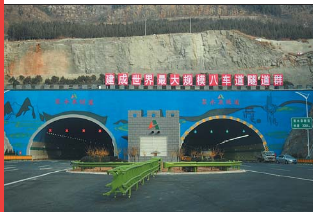
▲2017年12月22日,济南头号立交桥——搬倒井立交桥和周围的6个大型隧道通车在即。 本报记者 周青先 摄
