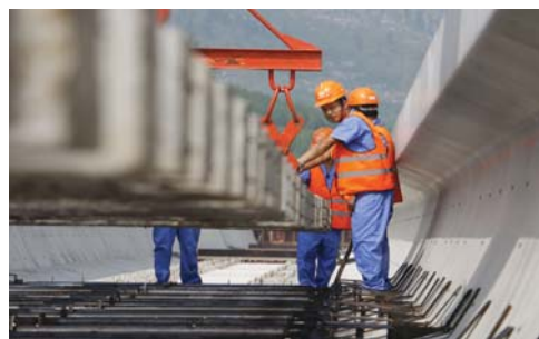
2017年8月20日,R1线高架段开始铺轨。本报记者 王媛 摄
