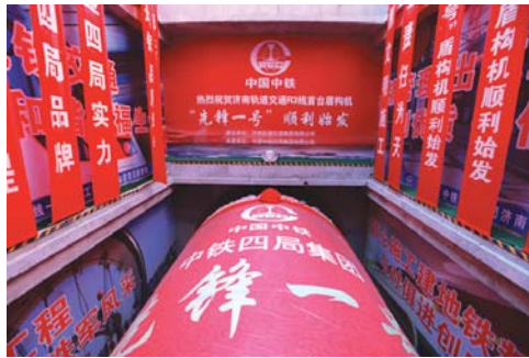
R3线首台盾构机始发。(济南轨道交通集团提供)
