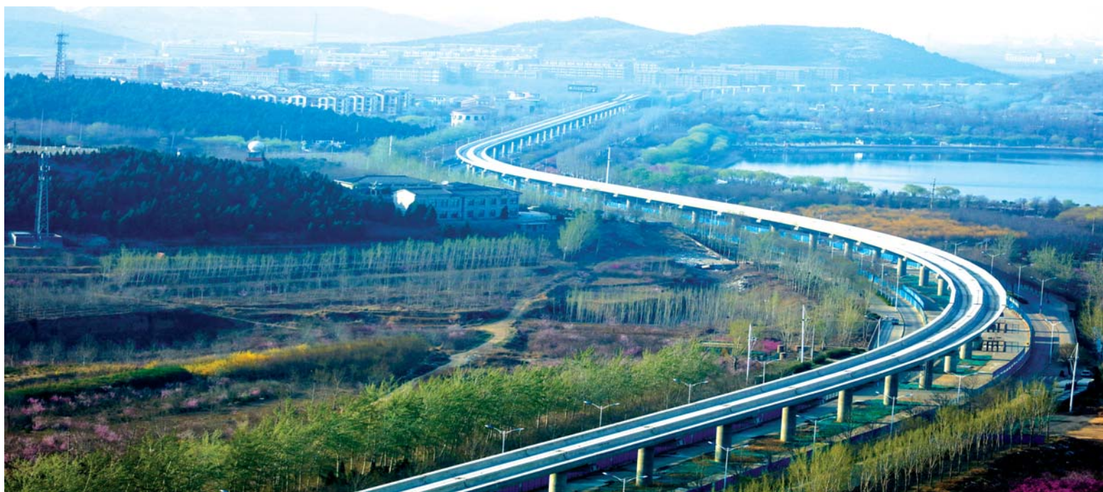
济南轨道交通R1线长清湖段。(济南轨道交通集团提供)
