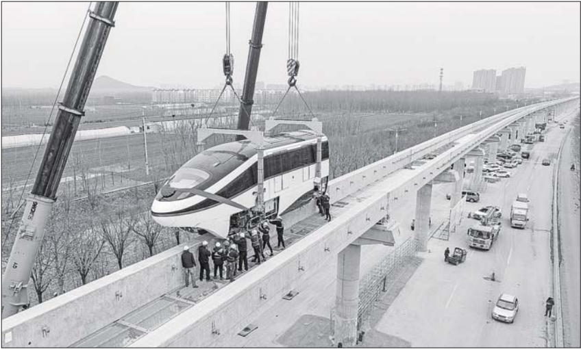
1月3日,吊车将云轨车辆吊上轨道。本报记者 李岩松 摄
