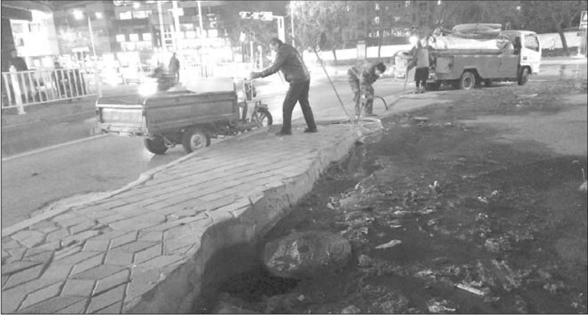
维修人员正在对下水井进行疏通。
