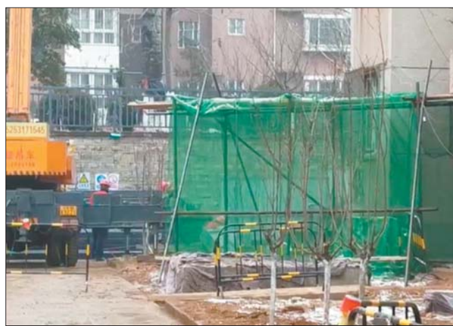
小区安装电梯正在施工中。直播截图
