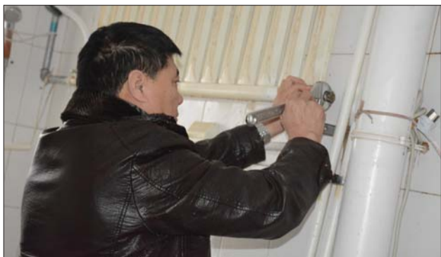
运河热力公司维修人员为田奇卓家冲洗暖气片。
