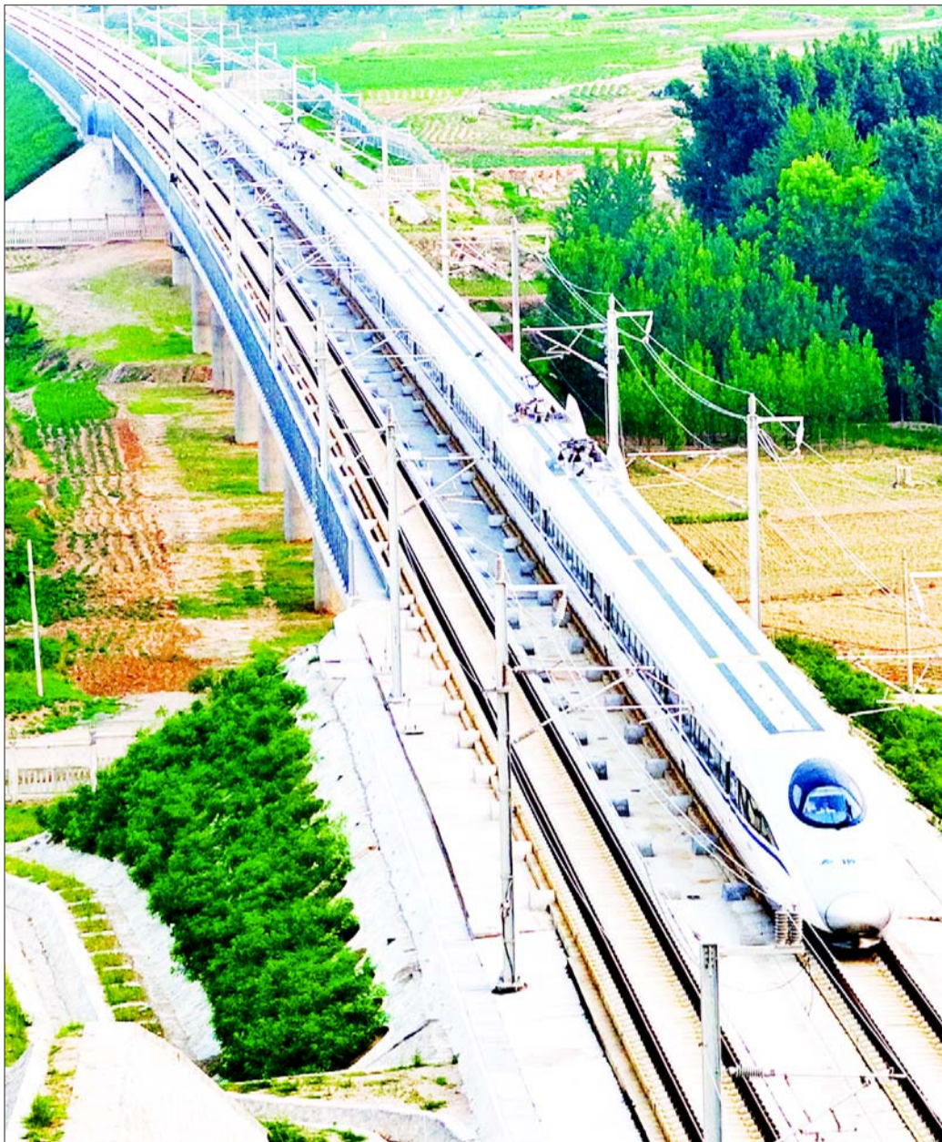
中国电建承建京沪高铁3标段,成为全面掌握具有世界领先水平高速铁路建设技术的企业之一。
