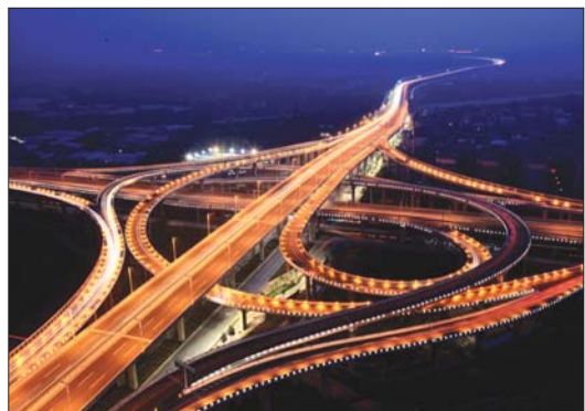
由中电建路桥集团承建的郑州市三环路快速化工程BT项目,先后荣获国家“金杯示范工程”等多项国家级奖项。
