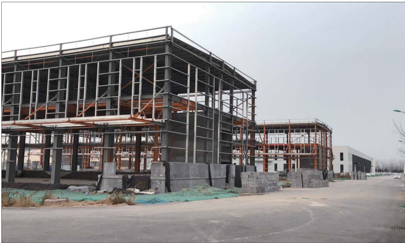
济宁高新区中通速递鲁西南快递电商产业园正在建设中。
