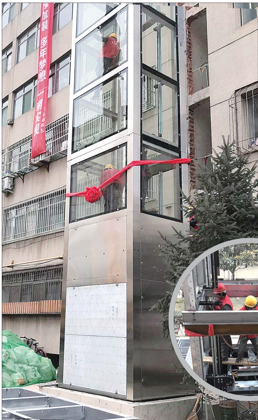
老楼加装电梯施工现场。
