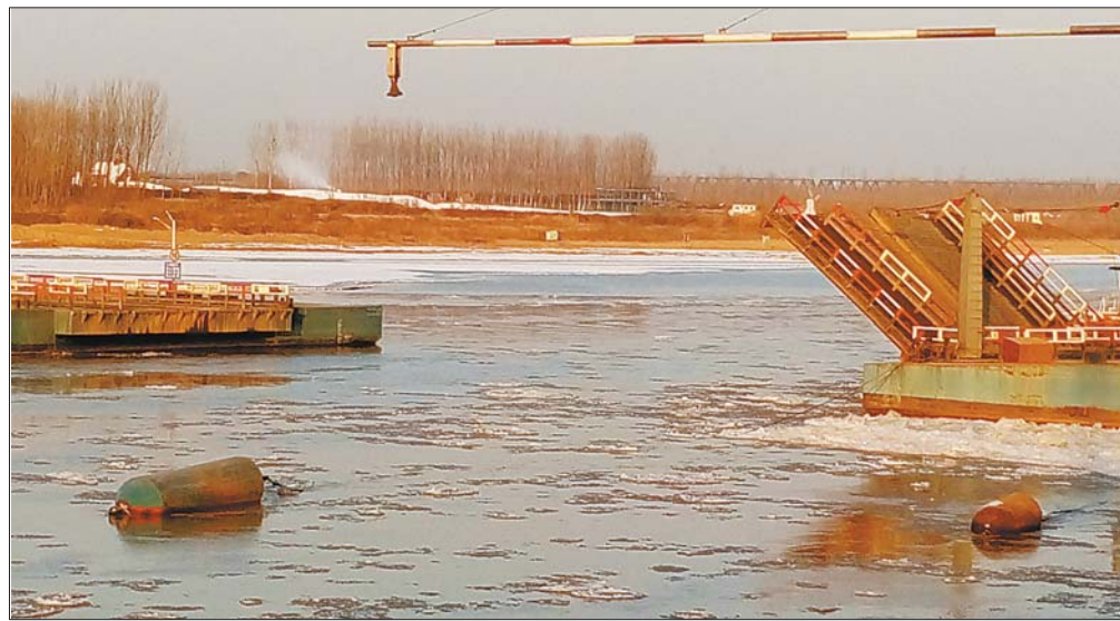
1月29日下午,黄河济南段冻口浮桥被拆除。 本报记者 周青先 摄
