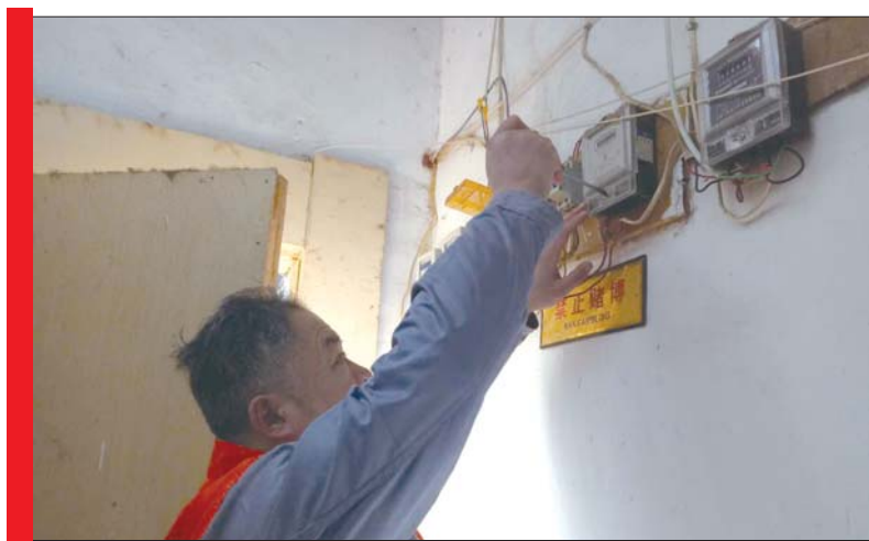
胡同管家维修电路。
