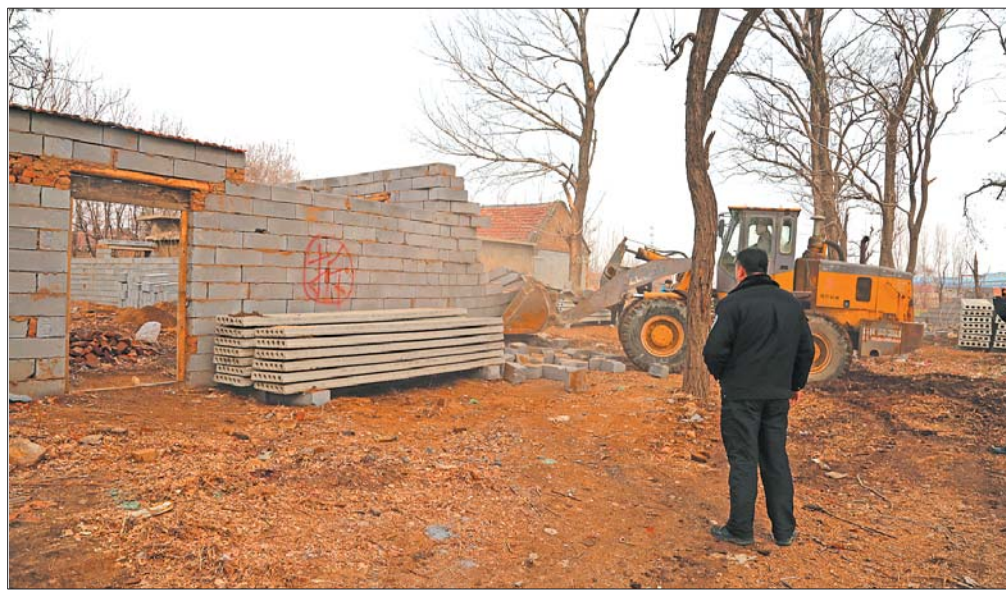
双山街道正在对违建进行拆除。
