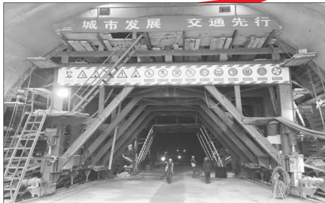
车脚山隧道北洞(西线)正在施工。本报记者 刘飞跃 摄
