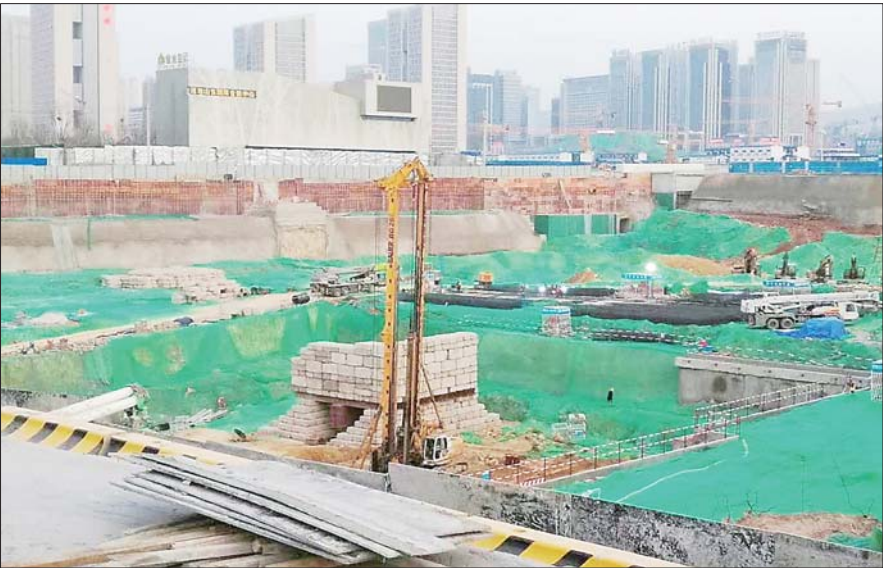
▲绿地国际金融中心主楼进入静载试验阶段。
