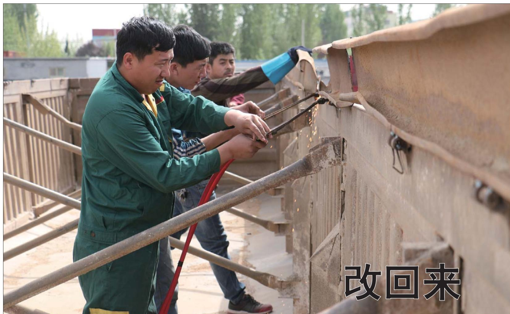
11日上午,济宁高新区交警大队强制切割拆解近期查处的6辆超载改型货车,经测量发现,这6辆货车车体全部加高,并非法加装了高达20公分的围栏,也就意味着车辆能够比合法标载多装10余吨货物。当日,专业切割人员逐一切割拆解了上述货车的围栏。
