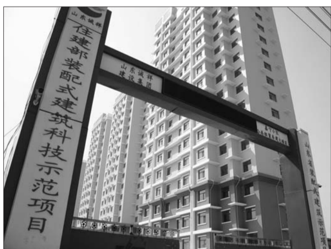
嘉宁小区采用装配式钢结构建筑。 本报记者 孙璇 摄
