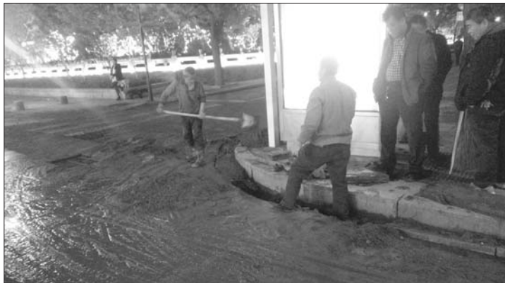
自来水公司工作人员正对损坏水管进行抢修。
