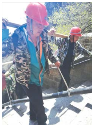
两人一组肩扛着电缆。
