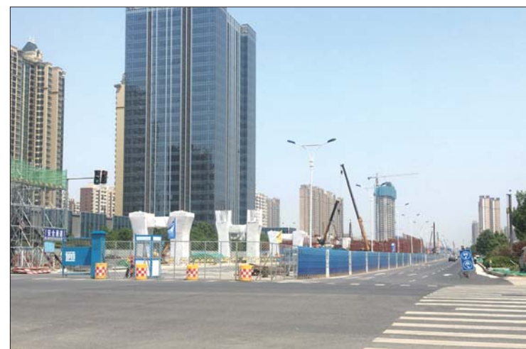
北园高架西延墩柱正在建设中。 本报记者 刘飞跃 摄
