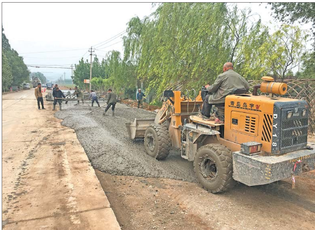
路面铺设目前已完成90%,预计本月底前竣工。 本报记者 张帅 摄
