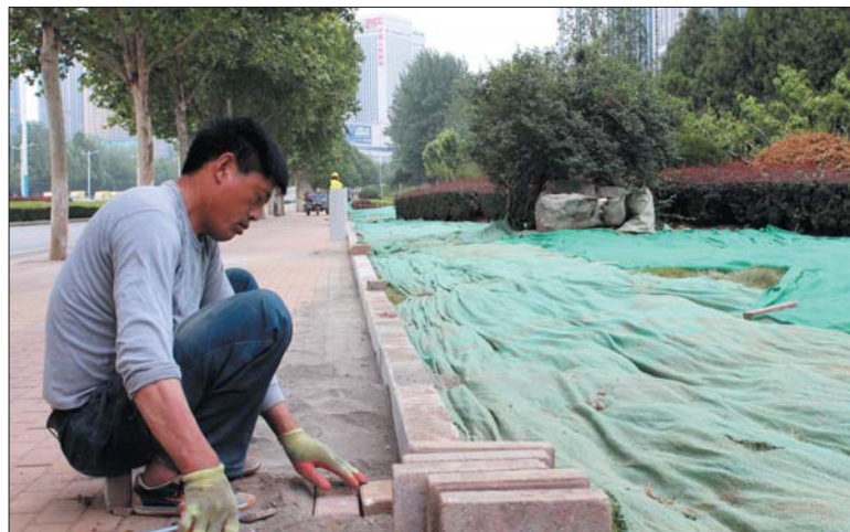
重新铺设路沿石。
