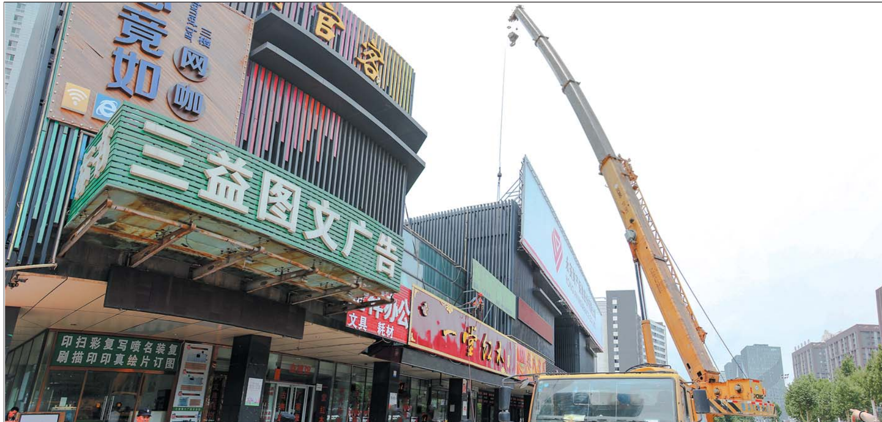
楼顶牌匾清理。
