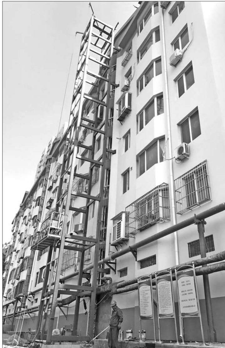
济南市历下区开元山庄社区1号楼3单元加装电梯在施工中。
