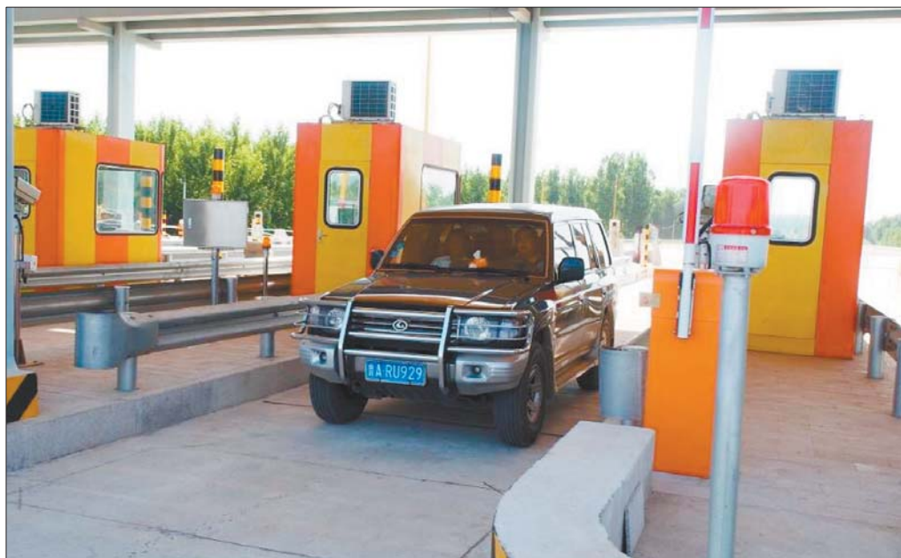
一辆越野车驶过收费站, 5月31日, 济南长清黄河大桥试运营。
