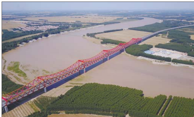
济南长清黄河公路大桥航拍图。
