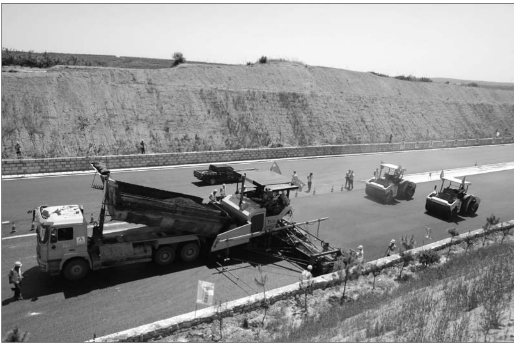
现场施工图。 通讯员供图
