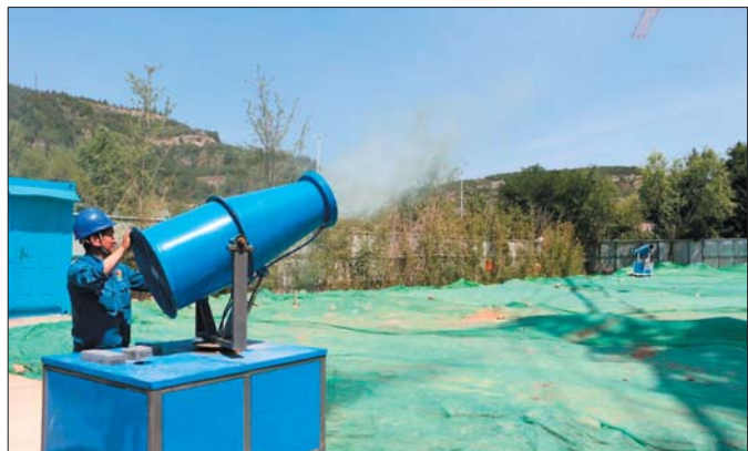
施工过程中积极做好扬尘治理。 东泰热力供图
