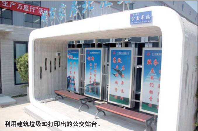
利用建筑垃圾3D打印出的公交站台。
