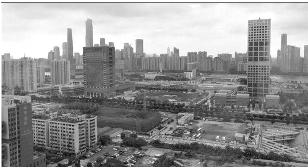
珠江南岸,占地2.1平方公里的广州市海珠区琶洲互联网创新集聚区起步区,工地塔吊林立。 新锐大众发
