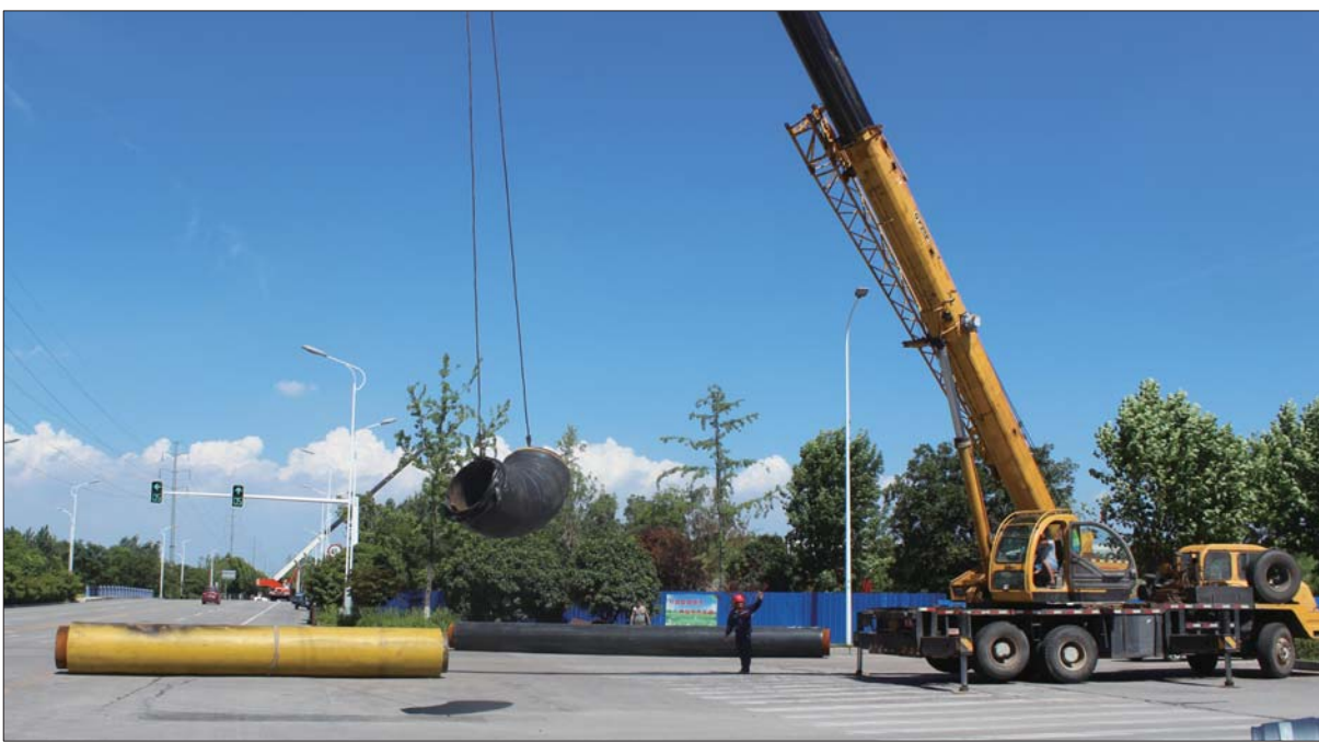
起重机正在吊装管道。
