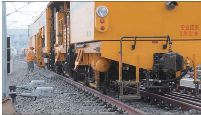
大型铁路捣固车正在站线上施工作业。
