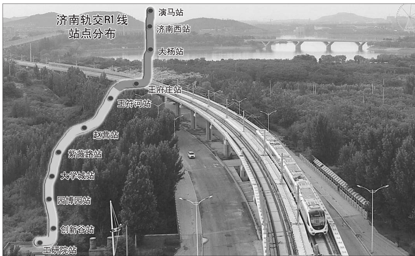
15日,济南轨交R1线首列车开始在高架段玉符河站至工研院站7个车站区间进行热滑。
